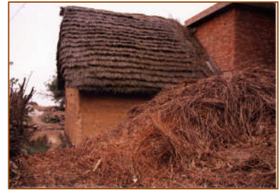
蕎麦葺き屋根の民家
